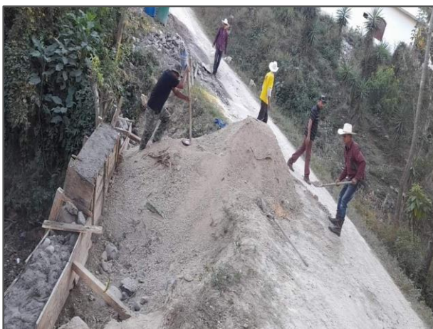
Construcción de Muro de Piedra ligada con cemento
