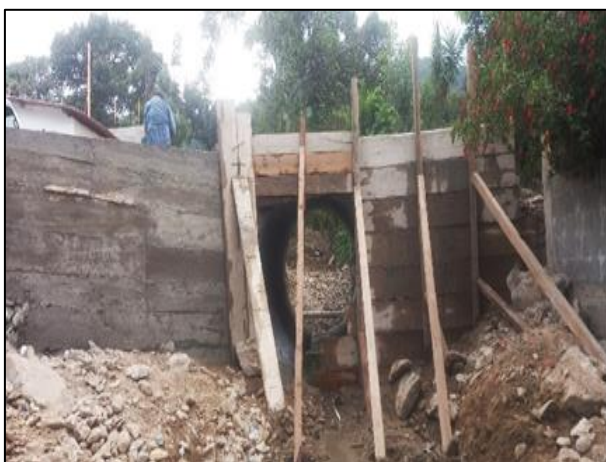
Colocación de tubería de metal corrugado de 96"
