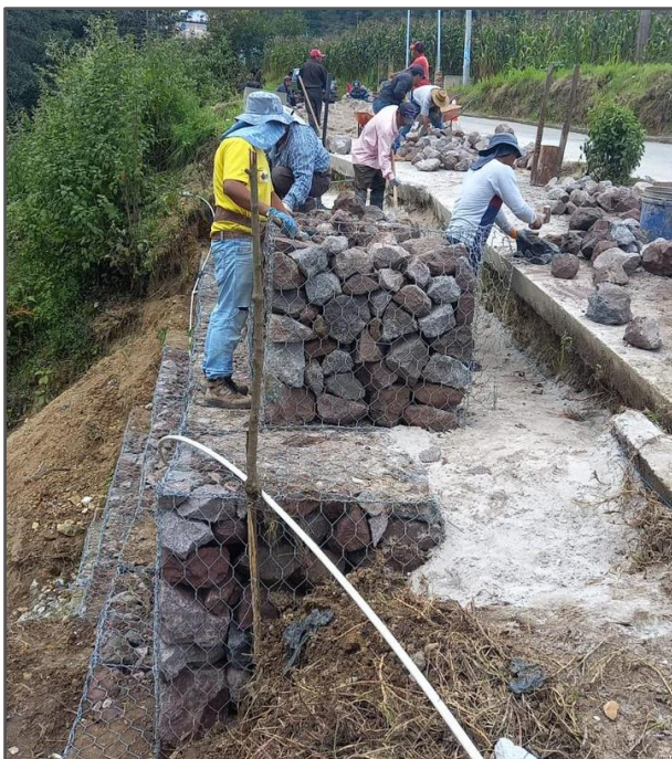
Construcción de Muro de retención de gaviones.
